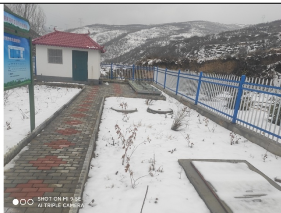
设备间及埋式一体化污水处理设施
