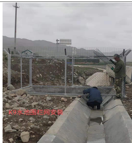
K9+715 处应急事故池
