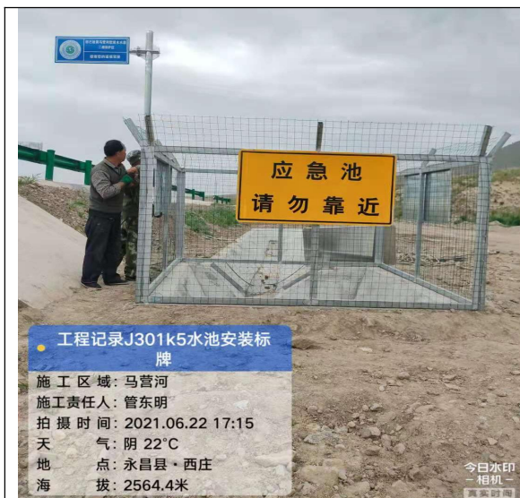
马营沟 2 号桥应急事故池 (K5+860)
